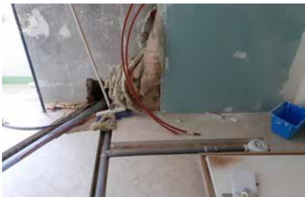
Création de nouvelles évacuations d'eau.
