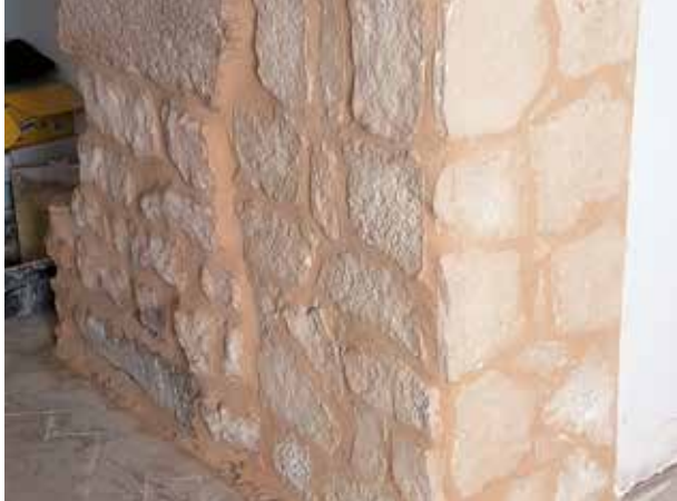
Montage de pierres de parement et jointement des pierres.
