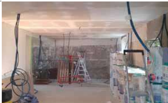
Vue d'ensemble du chantier.
