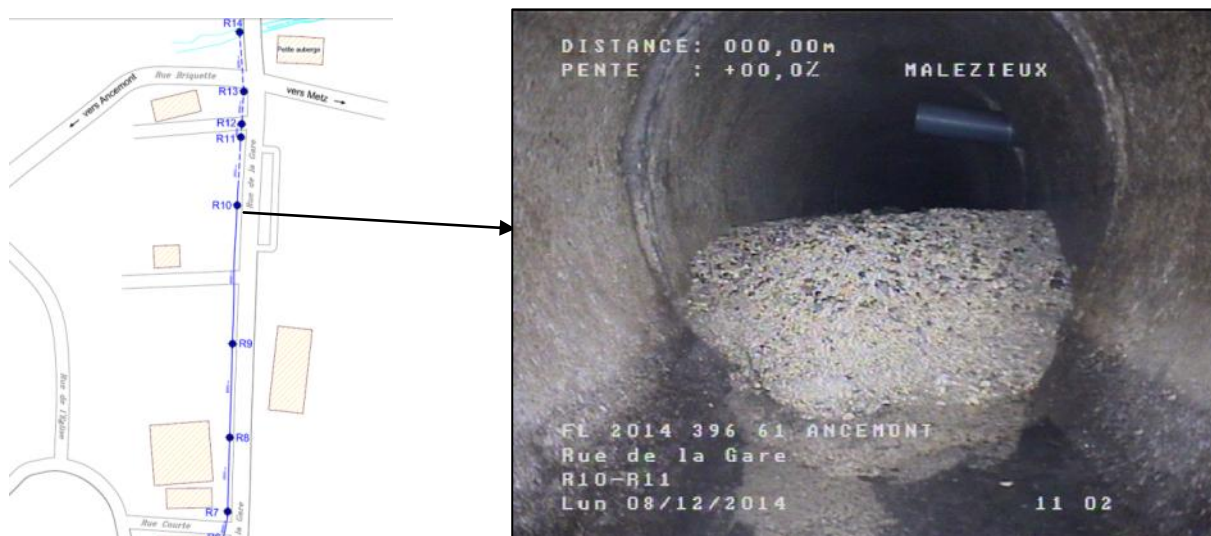
Figure 37 : Emplacement du béton dans le réseau d'eaux pluviales dans la rue de la Gare à Ancemont Source : passage caméra - Malezieux - 2013
