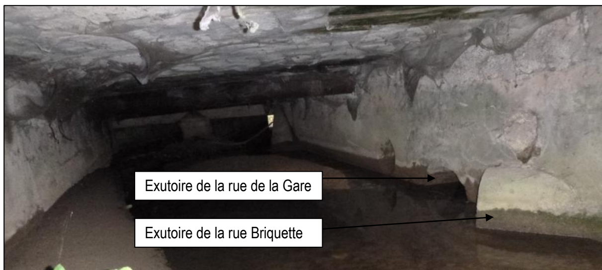
Figure 38 : Exutoires des réseaux d'eaux pluviales sous le pont de la RD34 Source : SINBIO – 21/10/2016
