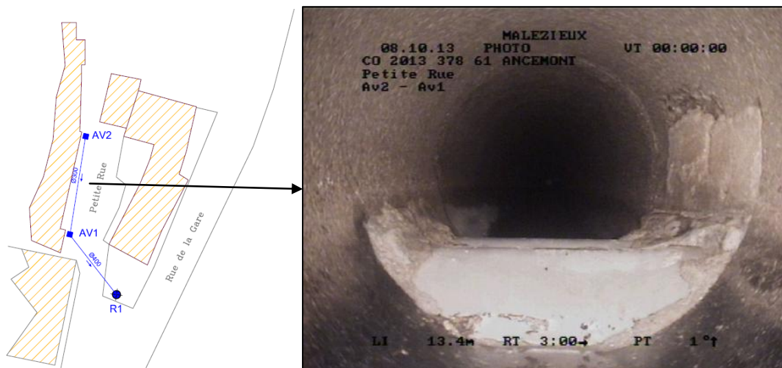
Figure 35 : Présences de tuyaux PVC réduisant la section de la canalisation du réseau d'eaux pluviales au niveau de la Petite Rue. Source : passage caméra - Malezieux - 2013
