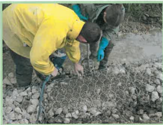
Réalisation d'un gabion végétalisé
