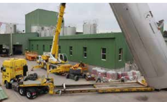
Installation d'un tank
